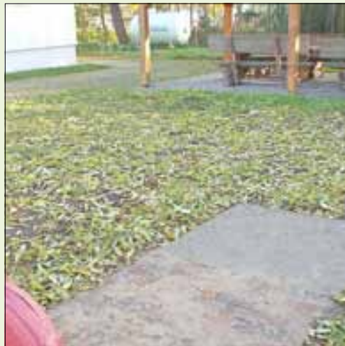
Das Fundament für die „Bücherzelle“ am Begegnungshaus Sausedlitz ist gebaut
