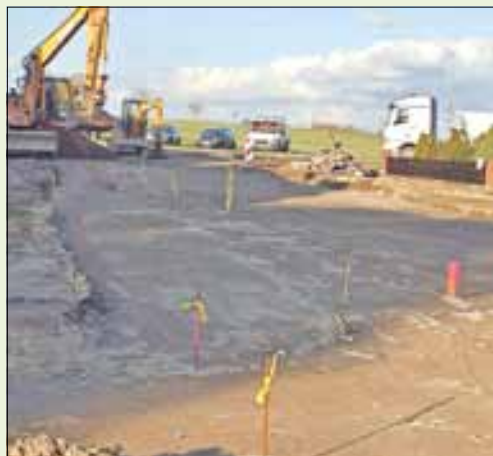
Ausbau der Stichstraße Teichstraße in Reibitz
