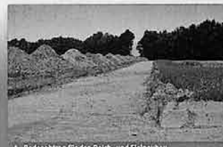
▲ Bodenabtrag für den Deich- und Sielneubau
