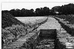
▲ Sodenabtrag für den Deichneubau
