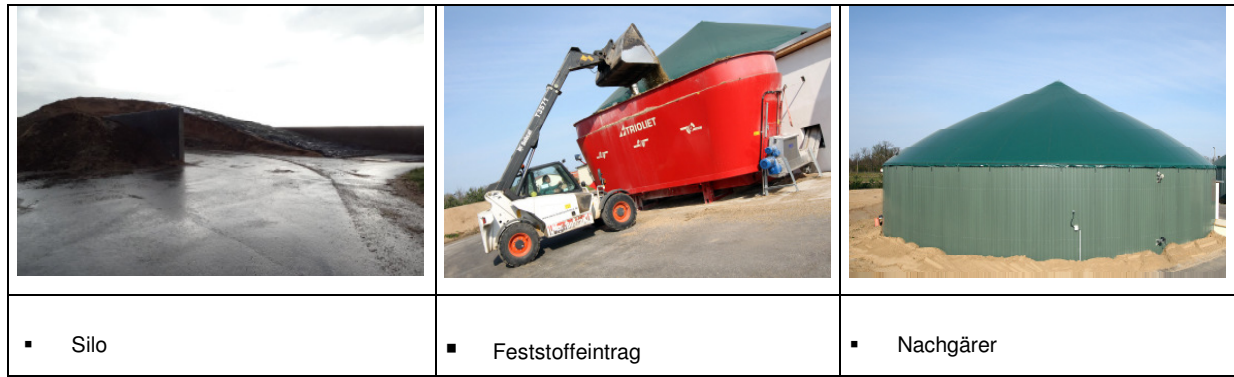
Abb. 3: gegenwärtiger baulicher Bestand am Standort der Biogasanlage (Auswahl)
