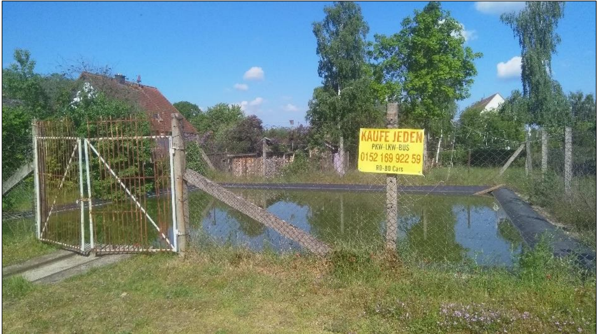
Abb. 4: Löschteich mit abgeflachten Betonwänden
