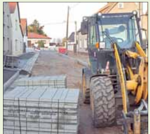
Ausbau der Straße Am Sandfeld in Roitzschjora Fotos: I. Ihle
