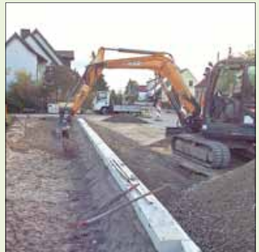
Beidseitig barrierefreier Ausbau der Bushaltestelle in der Raiffeisenstraße Löbnitz
