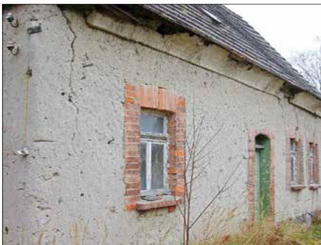
Das ehem. Tagelöhnerhaus wurde Mitte des 19. Jh. errichtet.
