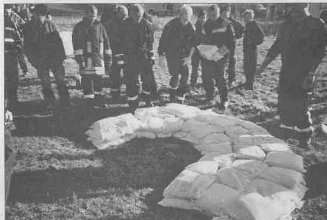
Hier erfolgt das Bilden einer so genannten Quell- und Kammkade (Böschungssicherung durch Sandsäcke).
