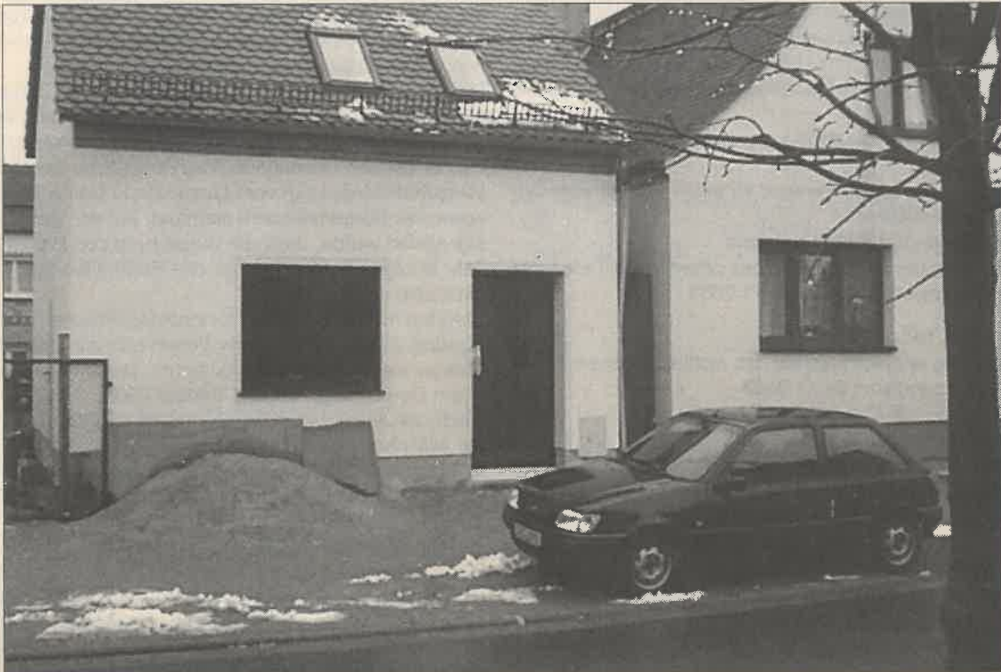
Noch zeugt der Sandhaufen vor dem neuen Gebäude, dass die Arbeiten nicht beendet sind. Pünktlich zum Eröffnungstermin wird die Sauna jedoch fertig sein.
