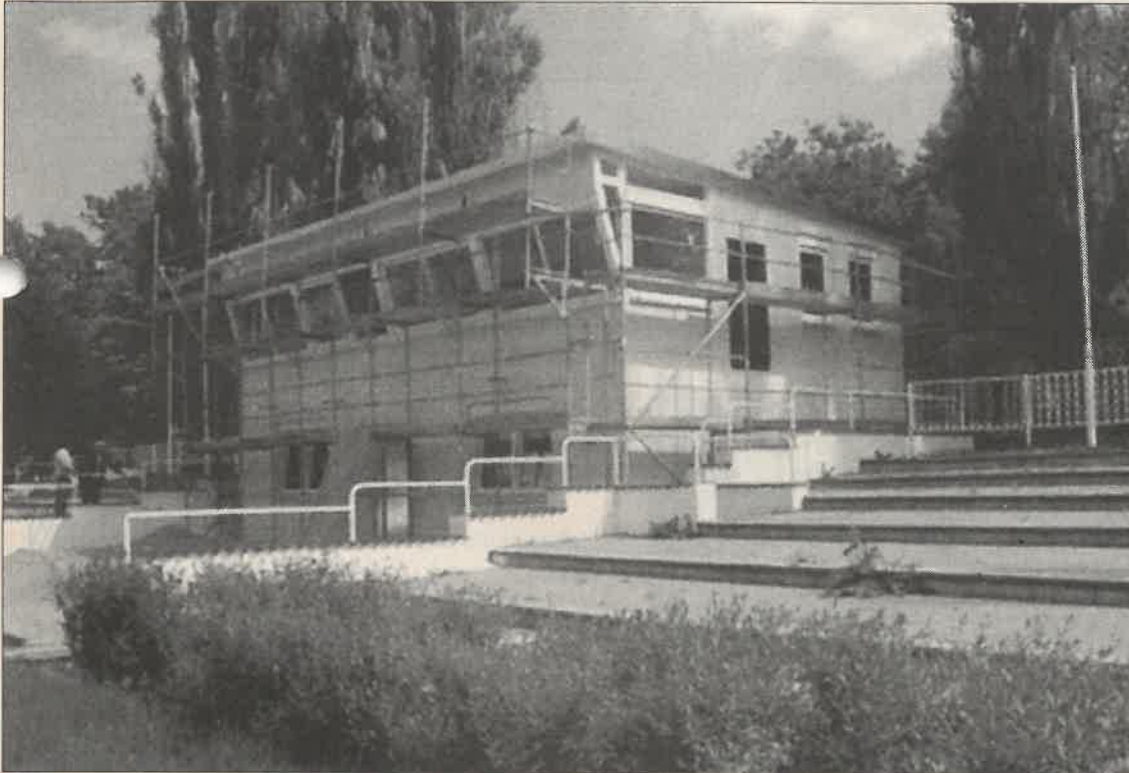
Noch eingepackt, lässt der Richterturm auf seine künftige Form und neuen Glanz schließen.
