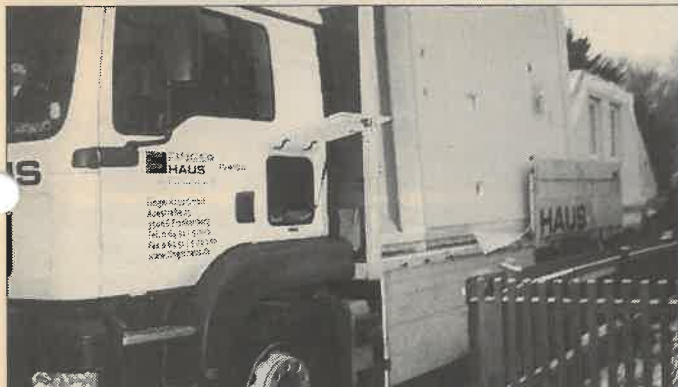
Die Bauteile des Fingerhauses werden angeliefert ...
